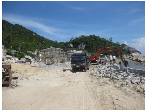
Xây dựng đường giao thông (CLC)
