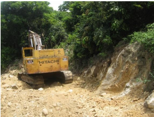
Xây dựng hồ chứa nước (CLC)
